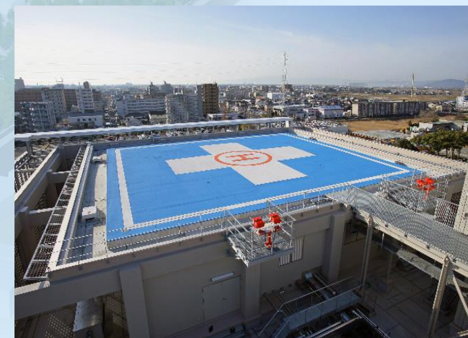
屋上ヘリポート
