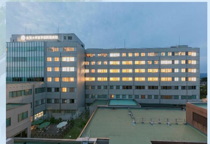
東病棟南より(夕景)
