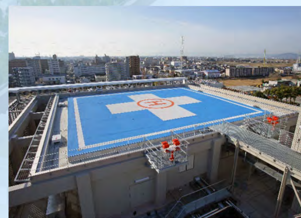
屋上ヘリポート
