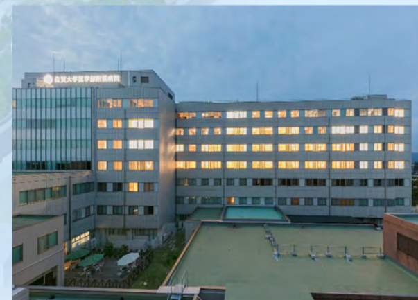
東病棟南より(夕景)
